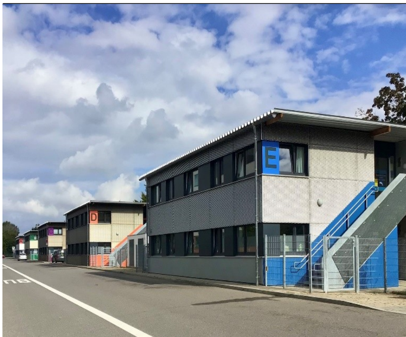
Abbildung 1: Kita am Schulzentrum, Sturm Katharina, 2023
