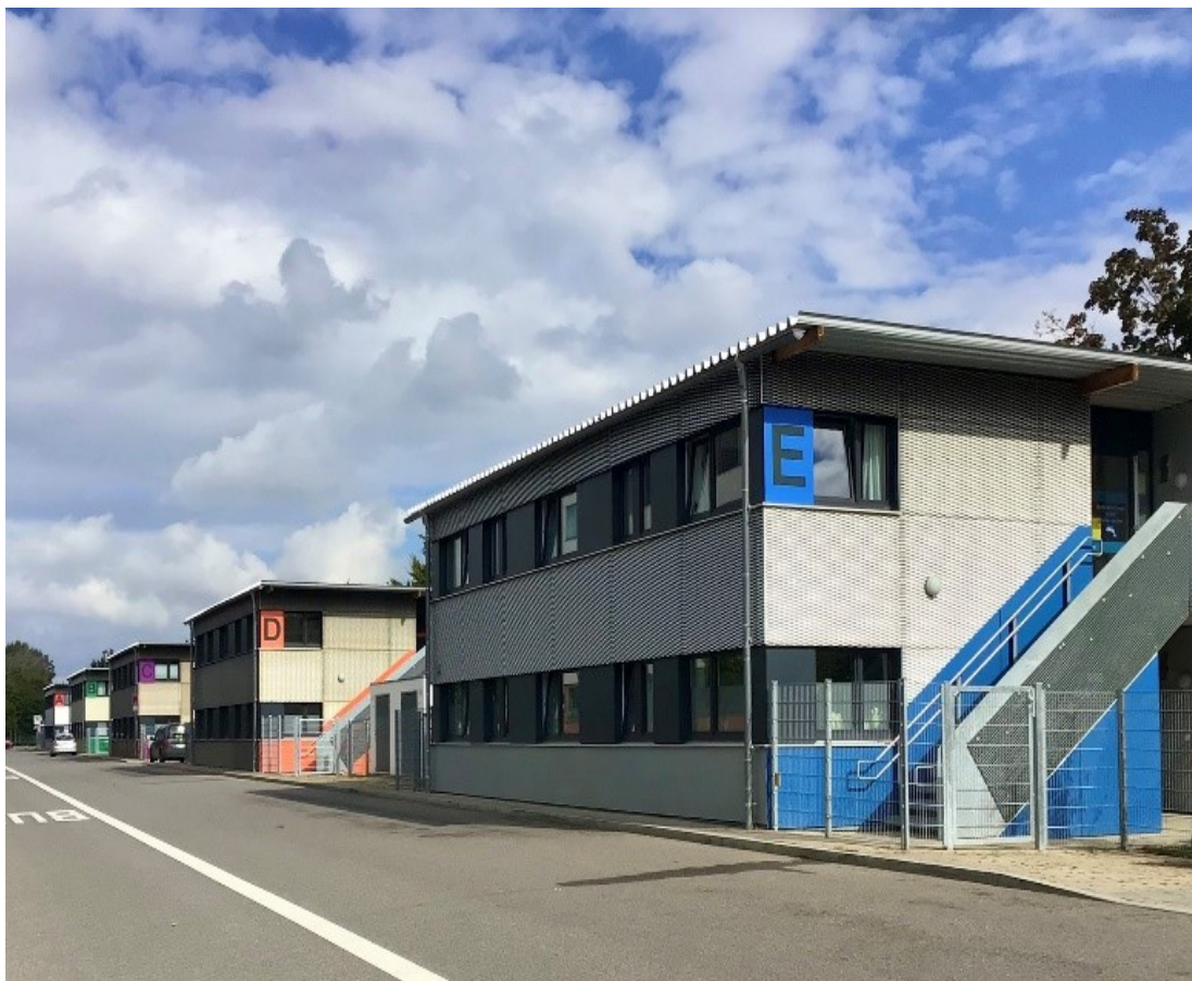
Abbildung 1: Kita am Schulzentrum, Sturm Katharina, 2023
